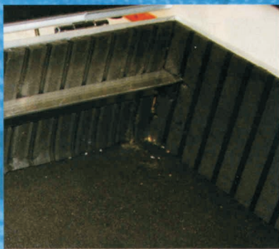
Die Tragleisten sind bereits befestigt.
